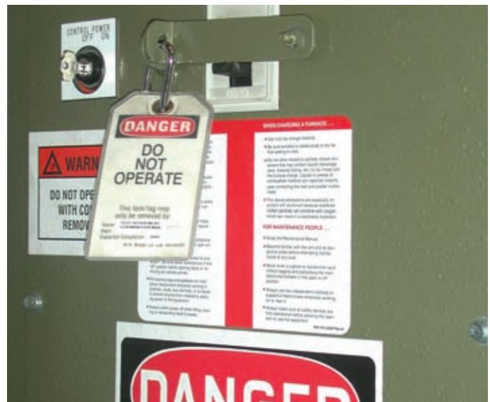
Самым безопасным способом предотвращения случайного включения питания во время обслуживания оборудования является система блокировки. Благодаря этой системе, человек, производящий работы по обслуживанию, использует замок, для обеспечения блокировки прерывателя в отключенном положении. Он или она хранят
